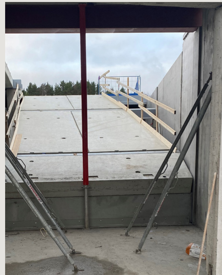
RAMPEN TILL INNERGÅRDEN I KV11, JÄRFÄLLA.
