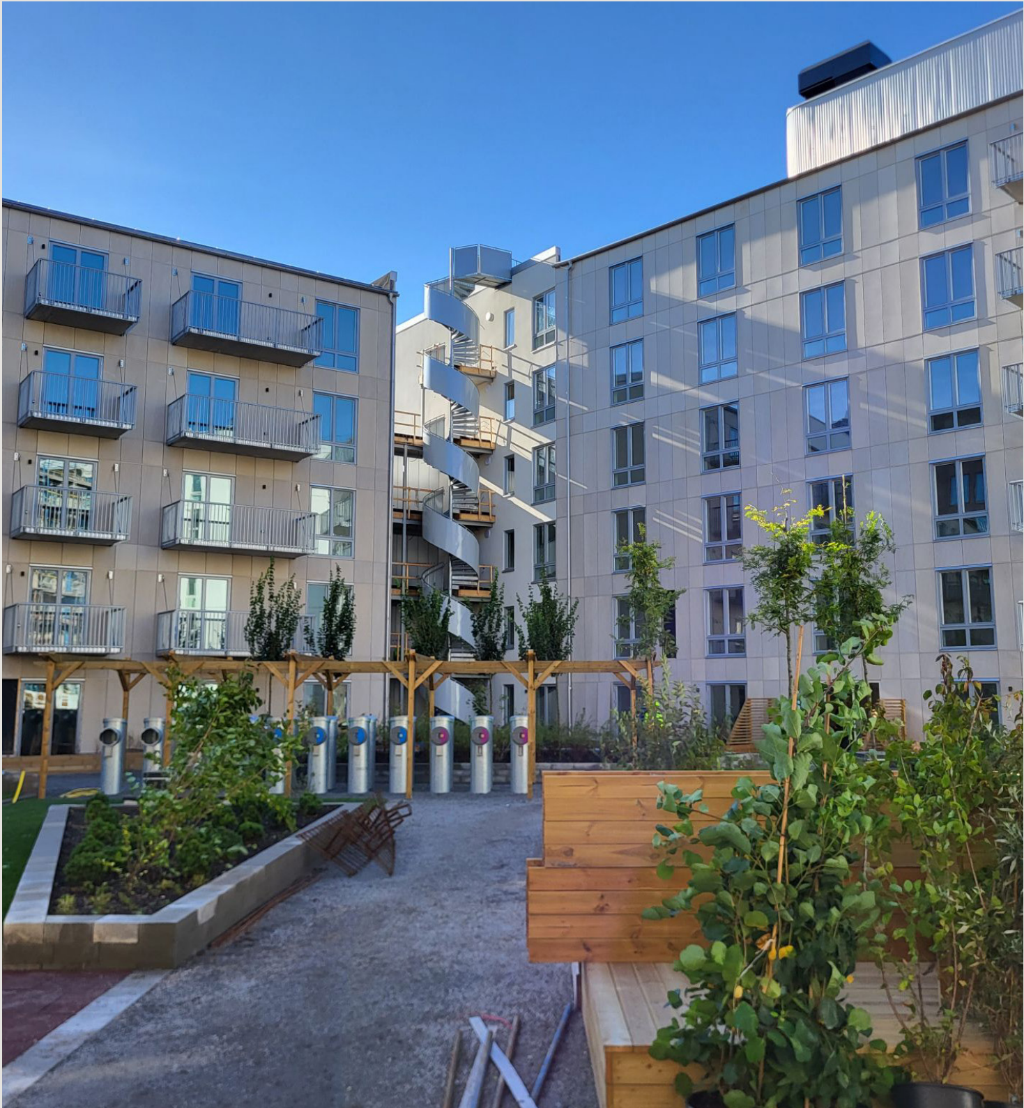
INNERGÅRD KV 11, JÄRFÄLLA
